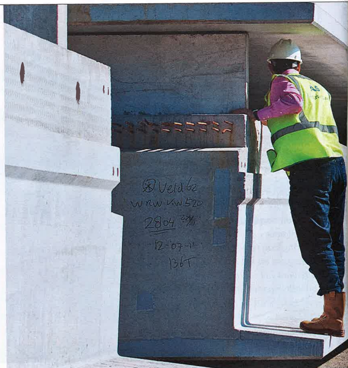
Een gedeeltelijk zij aanzicht van de Westrandweg, die voor 3,3 km van de totale 10 km als een viaduct is aangelegd en daarmee het langste viaduct van Nederland is.
