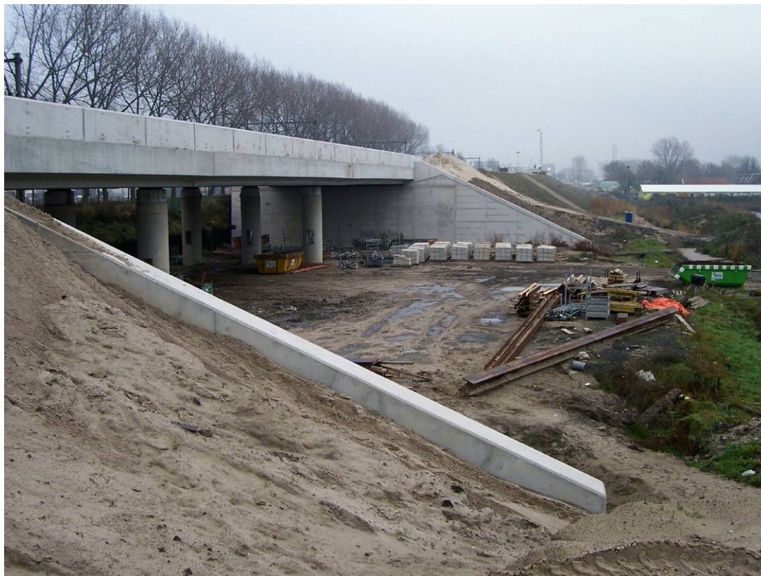
Project 'VLARK' – een door VHB gebouwd 'kunstwerk'
