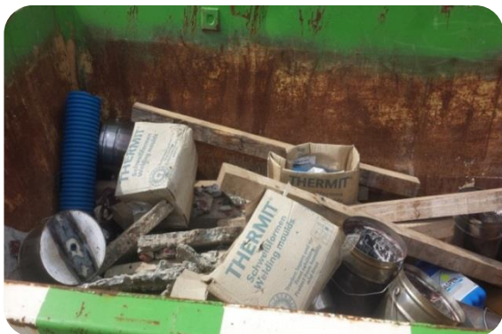
Figuur 5-2 Slecht gesorteerd bouw en sloopafval (BSA)
