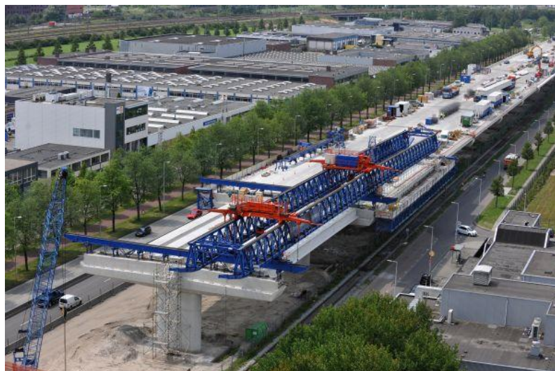
Figuur 2-5: Foto Westrandweg in de uitvoeringsfase. Dankzij verbeterde verhardingsbeheersingstechnieken (HyMoCo) is bij dit project een significante hoeveelheid CO 2 bespaard.
