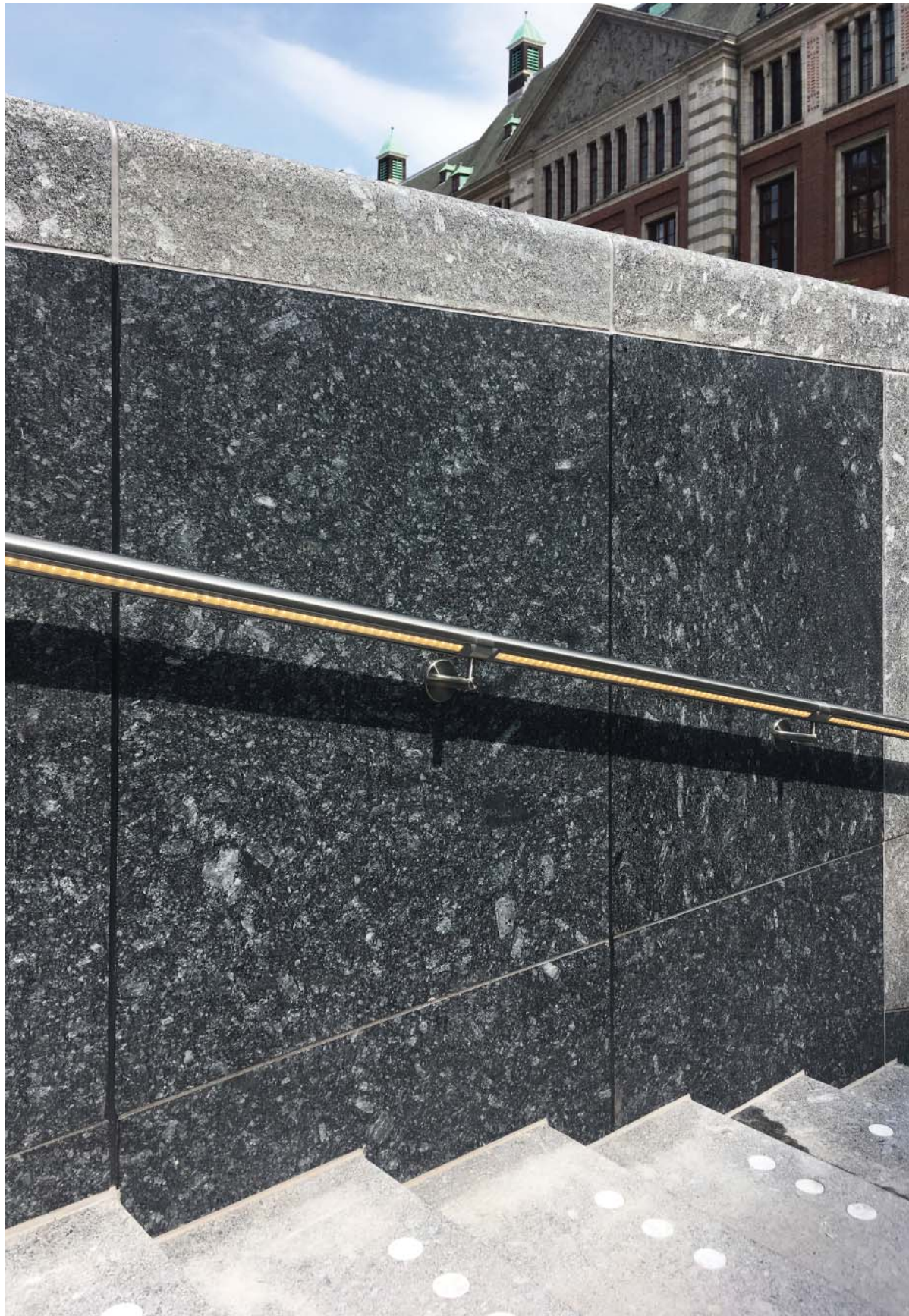
Detail van de balustrade langs fietstrap
