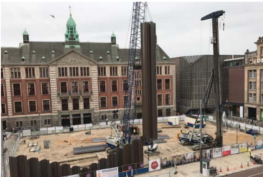
1 Damwand drukken en palen boren
